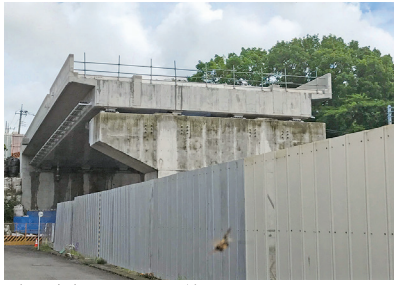
建設途中の3.4.24号線は？
